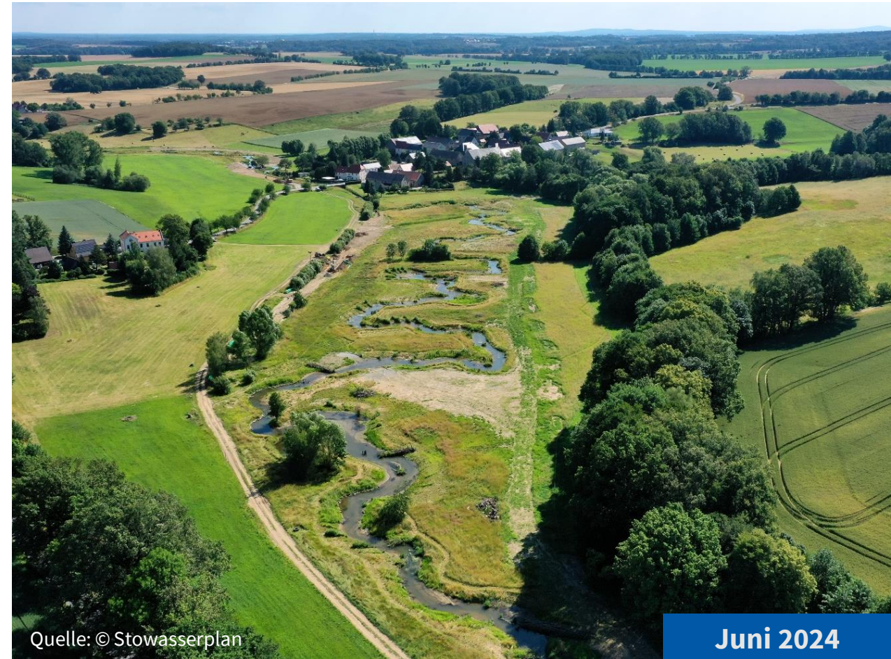
Zustand nach Fertigstellung
